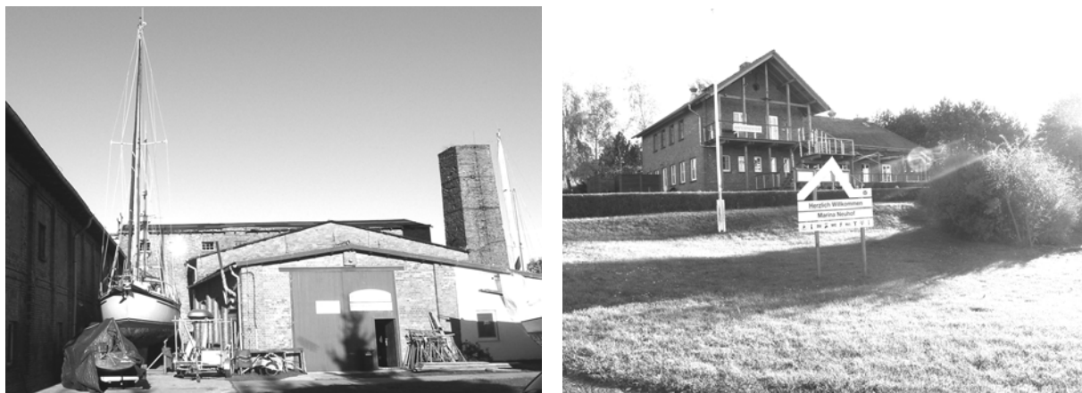
Abb. 3, 4: Nachnutzung der Ziegeleigebäude in Neuhof als Werkstatt / Verwaltungsgebäude
