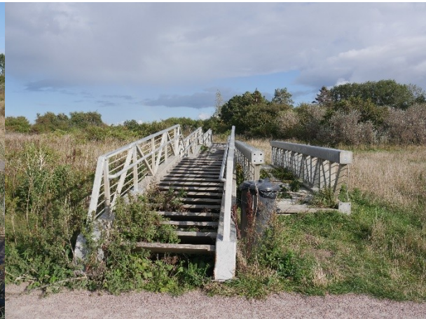
Abbildung 23: Die ehemalige saisonale Strandtreppe, die aufgrund des starken Rückgangs der Steilküste nicht mehr installiert werden kann (OSTSEEZEITUNG, 25.01.2022) (A.C. DE LA VEGA-LEINERT, 2022)
